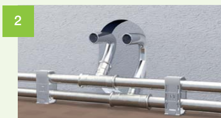
2 Проложить трубы, закрепить трубы в зажимах
