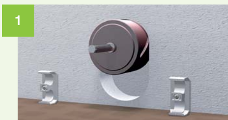
1 Вырезать отверстия в стене с помощью алмазной коронки. Установить зажимы.
