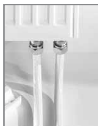
Подключение радиатора с использованием направляющего уголка
