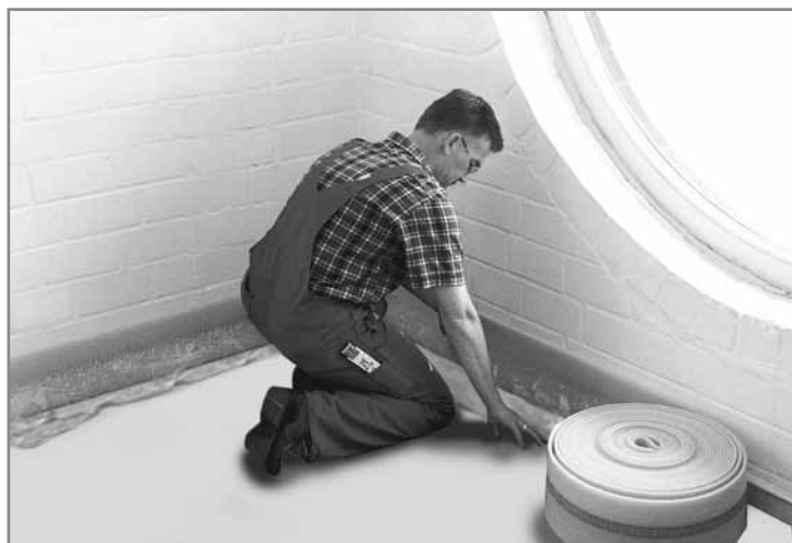
Укладка демпферной ленты
