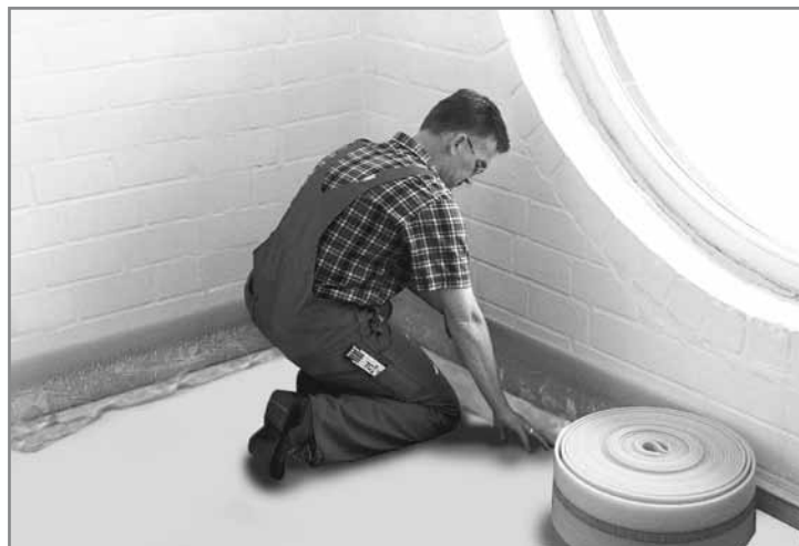
Укладка демпферной ленты
