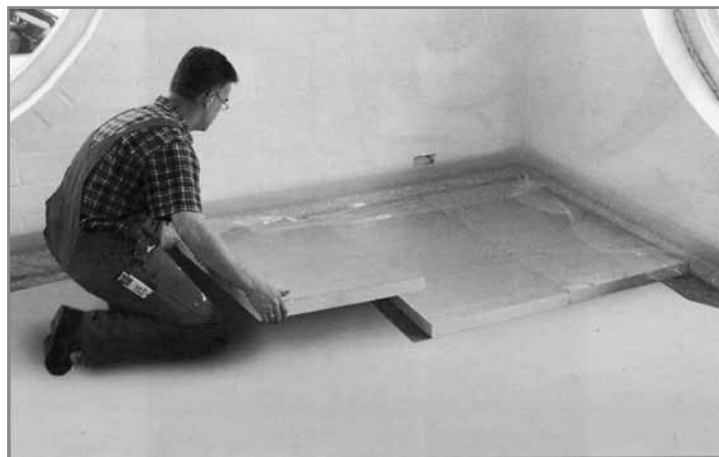
Укладка изоляции PUR
