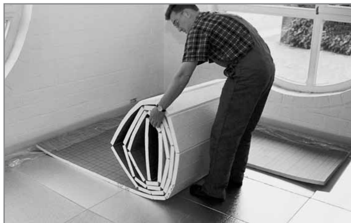
Укладка рулонной изоляции
