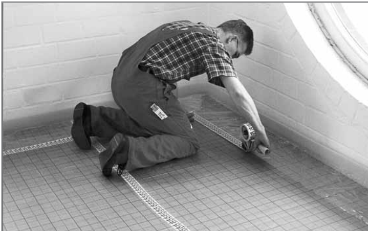
Уплотнение краевых изоляционных полос
